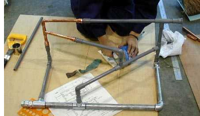
10) シールテープを除去して完成
