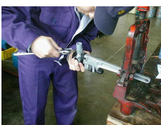
4) VS(バルブソケット)取り付け
