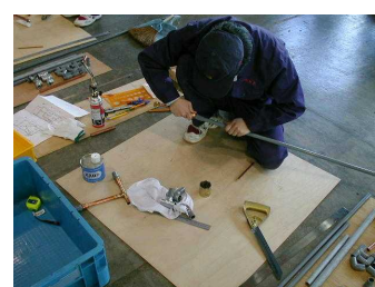
5) VP(硬質塩化ビニル管)仮切断
